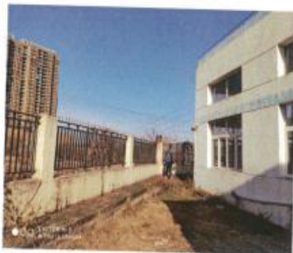
泵房东南侧噪声检测
