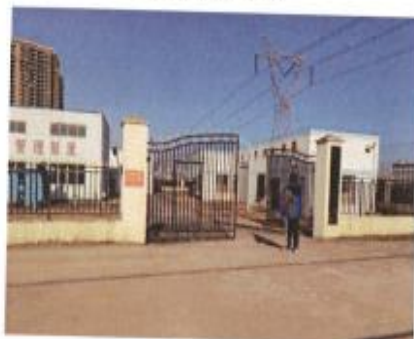
泵房西南侧噪声检测
